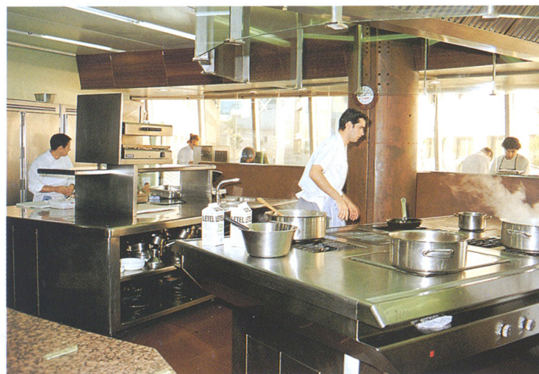
La cocina dispone de los más modernos equipos distribuidos de forma funcional para facilitar el trabajo y la rapidez de servicio
